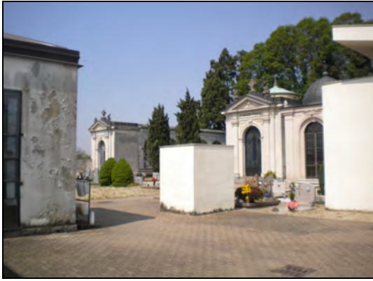
Fotografia n. 43 Cimitero di Campomorto: parte recente in proseguimento di quella storica
