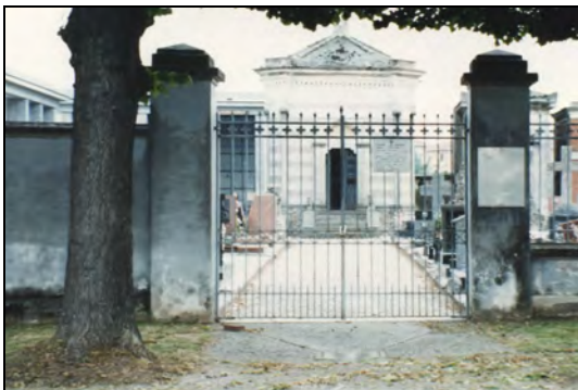
Fotografia n. 4 Cimitero di Siziano, parte storica: cancello su via Stazione
