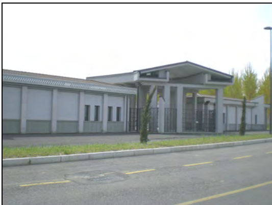
Fotografia n. 23 Cimitero di Siziano, parte nuova: portale di ingresso
