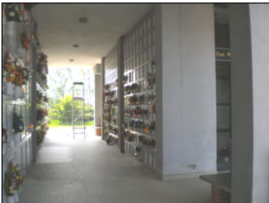
Fotografia n. 21 Cimitero di Siziano, parte nuova:loculi interni e cellette ossario
