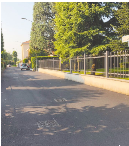
I lavori terminati in via Sacchi
